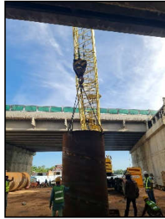
งานเจาะเสาเข็มสะพานข้ามแม่น้ำท่าจีน
