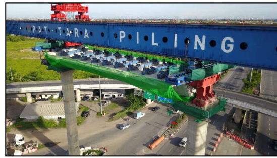
การติดตั้งชิ้นส่วนสะพาน (Segment) บริเวณทางแยกต่างระดับบางขุนเทียน กม.9+731
