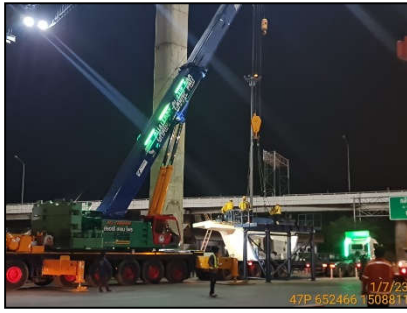
การติดตั้งชิ้นส่วนสะพาน (Segment) บริเวณทางแยกต่างระดับบางขุนเทียน กม.9+731
